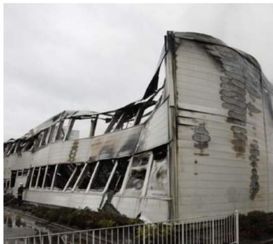
Le tristement célèbre collège Pailleron détruit par un incendie en 1973. L'État a construit 1067 établissements à structure métallique entre 1960 et 1975.
